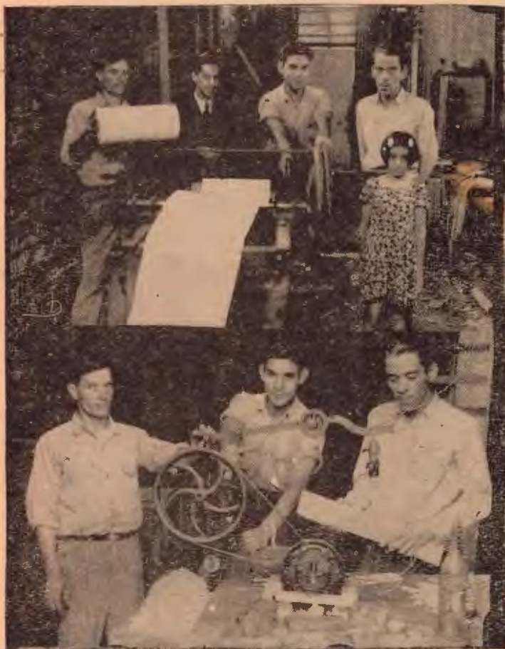
Aquí está el mecánico señor Bonilla, constructor de la ingeniosa máquina para laminar la madera que se usa en la elaboración de las cajitas y los palillos; en foto inferior, Navarro Cisneros mostrando el funcionamiento de la maquinilla para cortar los palillos.
